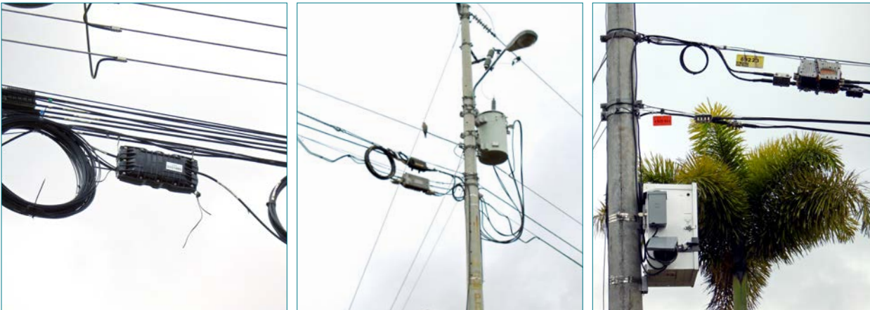
Figura IV. Redes aéreas de telecomunicaciones con elementos expuestos.
