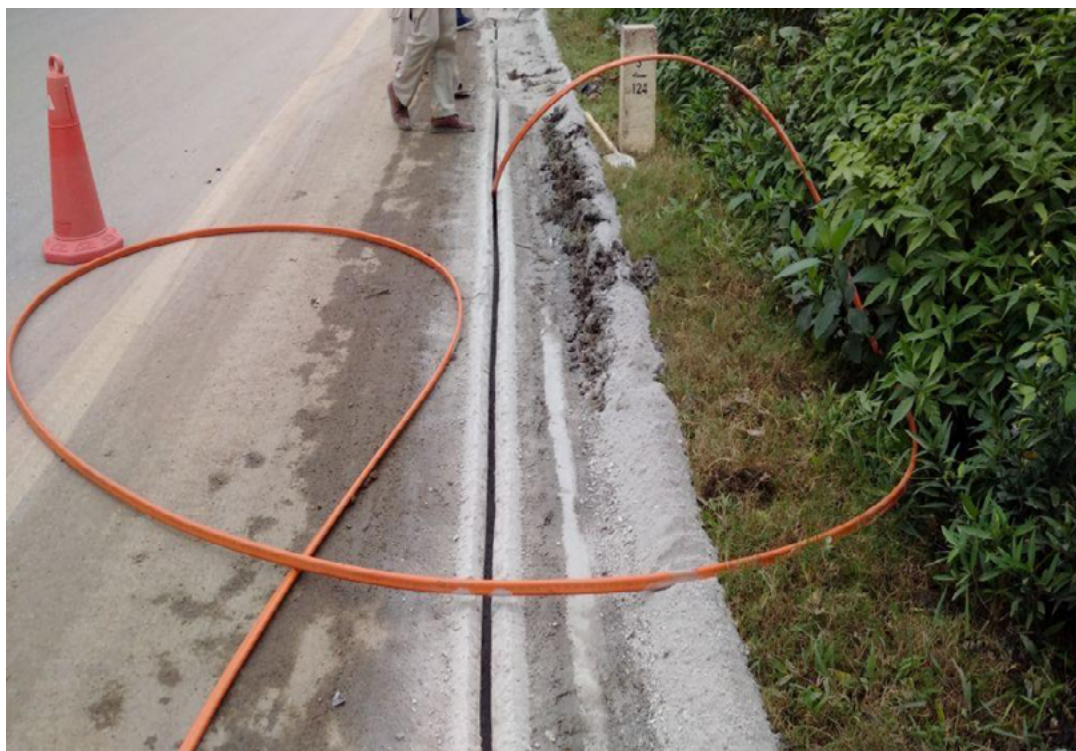
Figura 11. Ejemplo de microzanja en la banquina (berma) de un camino
